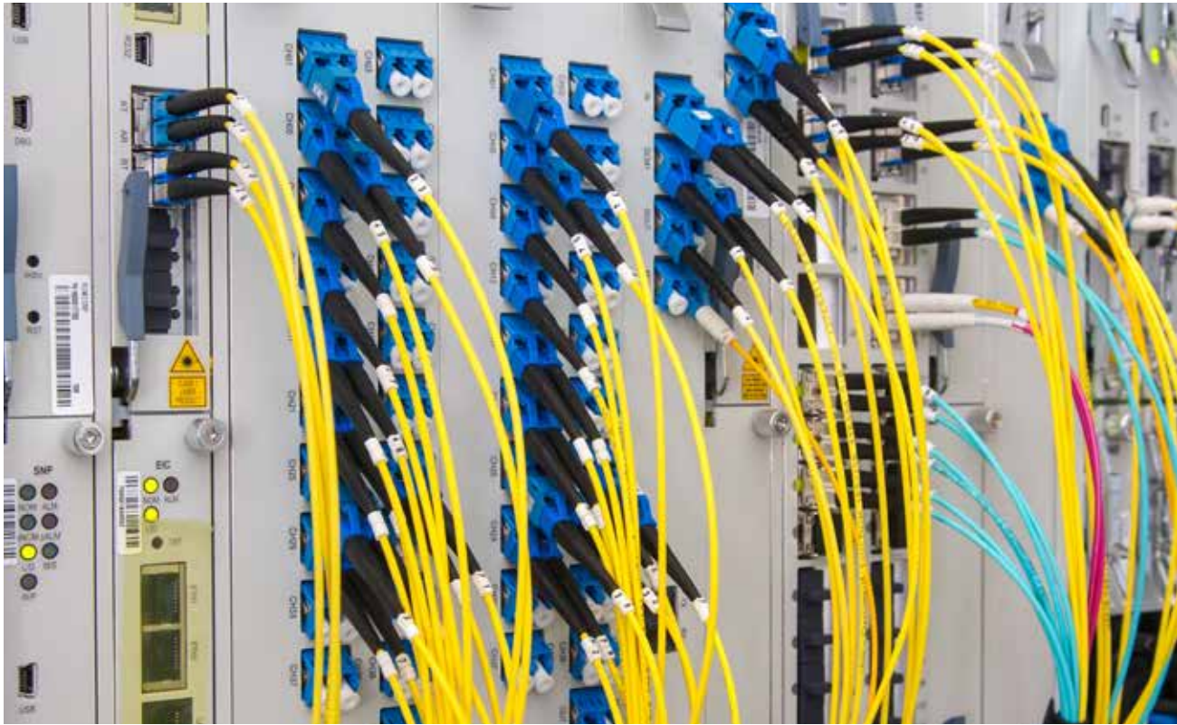
Netzkomponenten in einer Multimedia-Kopfstelle: Die leistungsfähige Glasfaser-Vernetzung im FTTB-Modell ermöglicht Internet-Geschwindigkeiten im Gigabit-Bereich und kann durch Anpassung der Clustergrößen laufend bedarfsgerecht ausgebaut werden.
