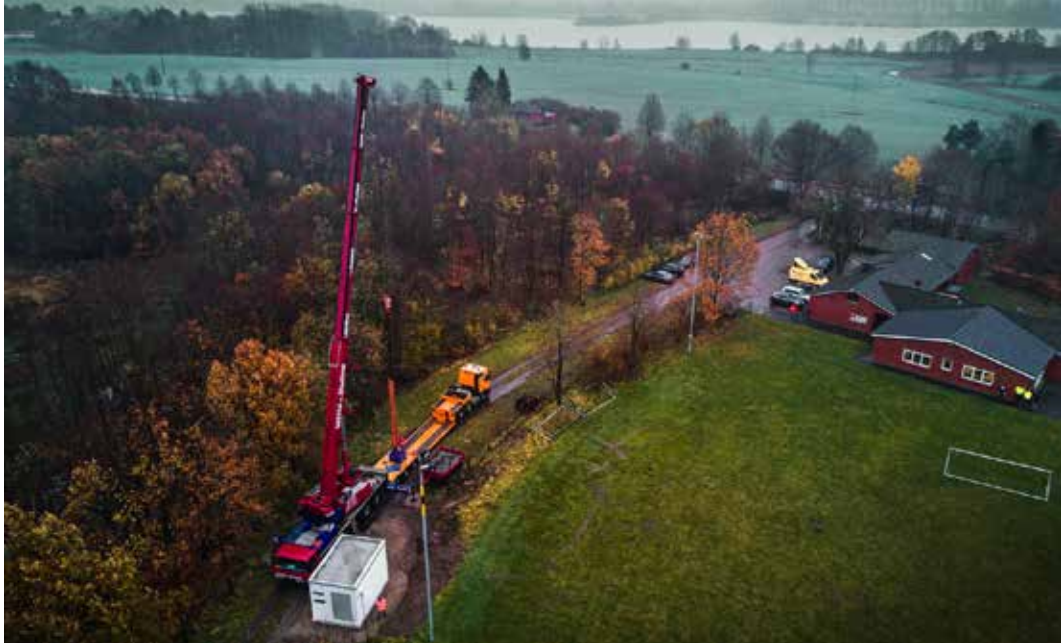
Installation der Multimedia-Kopfstelle in Pohnsdorf, Schleswig Holstein: Als Partner eines kommunalen Zweckverbands betreibt Tele Columbus das Glasfasernetz für 46 Gemeinden im Kreis Plön an der Ostseeküste.
